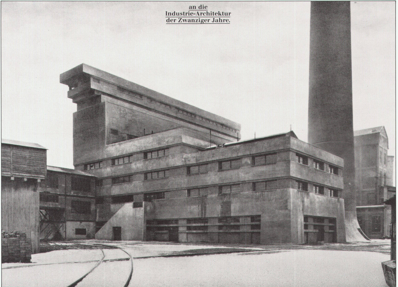
Kesselhaus des Werkes Königsberg i. Pr. Architekt: Edmund Meurin, Berlin
