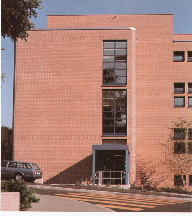
Röben-Klinker-Sichtmauerwerk als hinterlüftete, frostbeständige und unterhaltsfreie äussere Schale beim Zweischalen-Mauerwerk. Je nach Isolationsstärke k-Werte bis 0,3 W/m² K.
