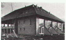
Wohnhaus Hofstatt, Kappel SO 01.07 Reihenhäuser Heft Nr. 9/1983 Architekten: B. und J. Fosco- Oppenheim, K. Vogt, Scherz
