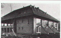
Wohnhaus Hofstatt, Kappel SO 01.07 Reihenhäuser Heft Nr. 9/1983 Architekten: B. und J. Fosco- Oppenheim, K. Vogt, Scherz
