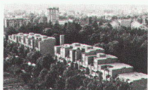
Genossenschaftliche Wohnbauten, Zürich 01.02/01 Mehrfamilienhäuser Heft Nr. 12/1982 Architekten: Kuhn + Stahel, Zürich
