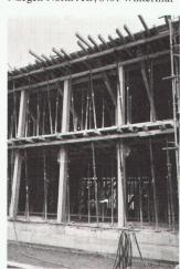
Bei einem Fabrikationsgebäude werden die Geschossdecken und das Dach durch standfeste Säulen abgestützt.
