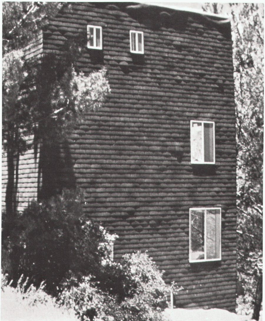
1 Ansicht von Westen mit dem Schlaftrakt im Vordergrund / Vue de l'ouest avec l'aile des chambres / View from West with bedroom wing
