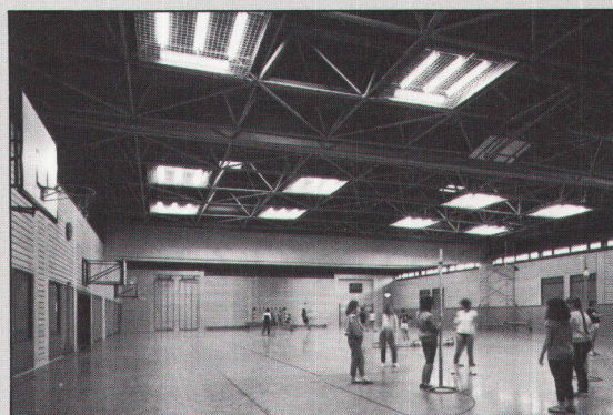
Dachkonstruktion der Sporthalle in Osnabrück-Eversberg. Das Raumfachwerk hat ein Rastermaß von 3,00 m.
