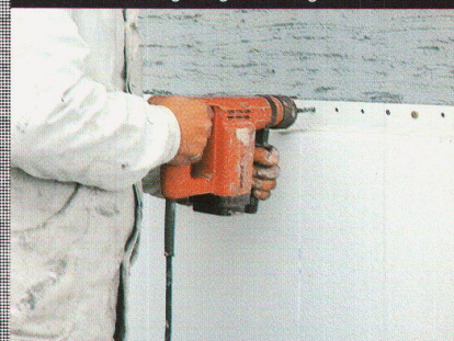
Montage der STO-Halteleisten.
