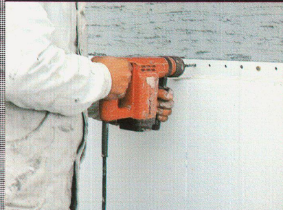
Montage der STO-Halteleisten.
