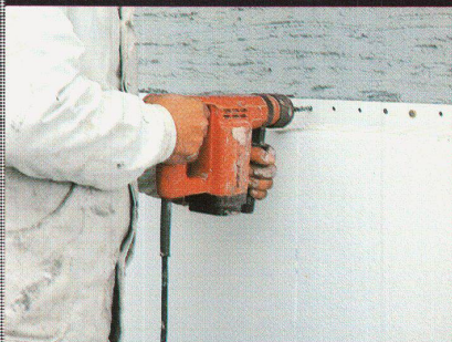
Montage der STO-Halteleisten.
