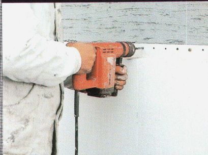
Montage der STO-Halteleisten.
