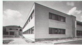
den Nutzlast und der geforderten Wärmeisolierung sind Elementstärken zwischen 10–25 cm bei Stützweiten bis max. 600 cm möglich.
