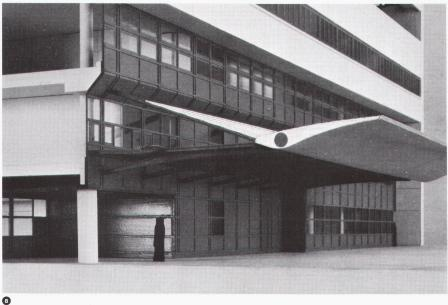
Detail Knoten der Aufhängelasche und des Abstützfusses / Détail du nœud de la suspente et de l'élément d'appui / Detail of joint of suspension strap and shoring plate
