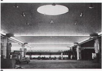
Die im Fliessexperiment erzeugten Formen geben Raumverhältnisse, die für die Nutzung günstig sind. Sie sind aber statisch erst tragfähig, wenn freie Ränder mit Randgliedern, Aufkantungen oder Abspannungen versehen werden.
