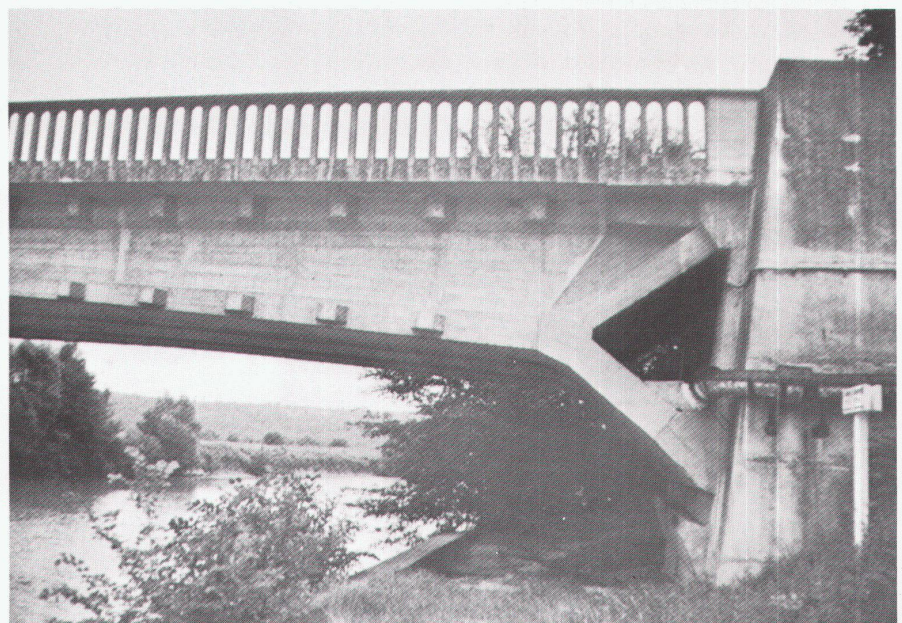
2 Dreieckige Auflager / Appui triangulaire / Triangular seating
