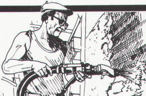
einen Schlag löst! Der Dämmputz wird auf die Welnet-Gitter aufgetragen, welche vorher direkt auf den Altplatz befestigt wurden – und fertig!
