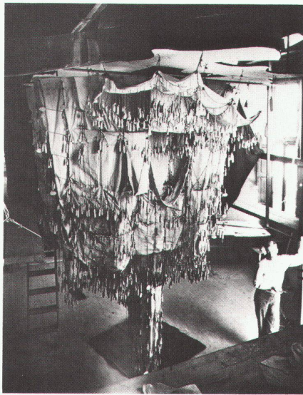
Original-Hängemodell von Gaudi. Aussenansicht der Kirche von Süden mit Treppenaufgang und Haupteingang. Im Foto ein Mitarbeiter Gaudis / Maquette en nappes de Gaudi. Vue extérieure sud de l'église avec l'escalier d'accès et l'entrée principale. Sur la photo, un collaborateur de Gaudi / The original suspension model by Gaudi. Exterior view of the church seen from the south, including its main entrance and the stairs leading to it
