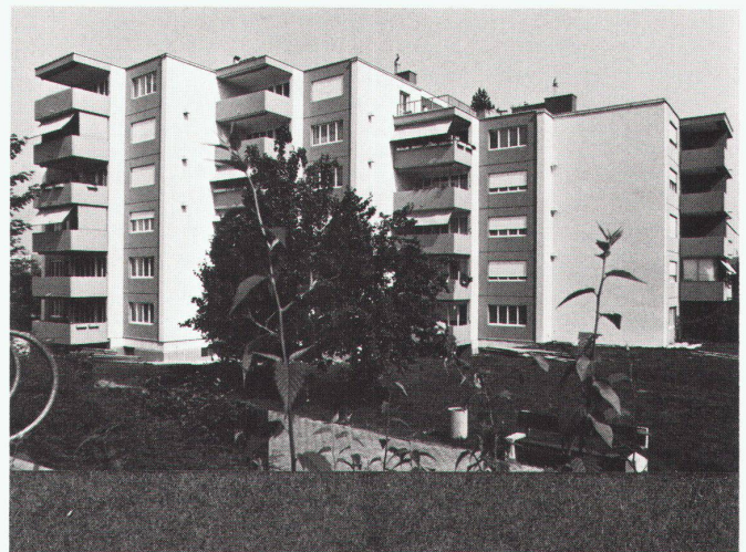
Die Überbauung nach der Sanierung
