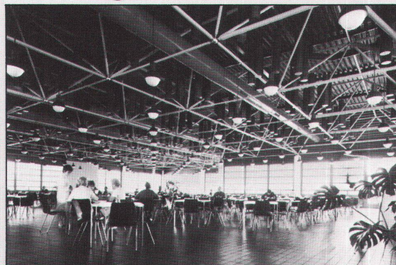
Robert Bosch GmbH, Werk Stuttgart-Feuerbach, Kasino. Das Raumfachwerk hat ein Rastermaß von 3,60 m
