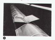
Durch diese Lichtbänder ist eine optimale Lichtverteilung in den darunterliegenden Räumen sichergestellt. Stegdoppelplatten, Plexiglasplatten, Polycarbonatplatten, plan oder gebogen, können aber auch für Pergolen, Treibhäuser, Unterstände für Autos, Velos und Personen (an Tram- und Busstationen) eingesetzt werden. (Foto 2.)
