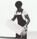
1 Gemauert als monolithische Fassade mit dem k-Wert 0,24W/m²K bei 35 cm Wandstärke. Qualität GL und 5 Gew.-% Feuchtigkeit.
