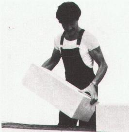
1 Gemauert als monolithische Fassade mit dem k-Wert 0,24 W/m<sup>2</sup>K bei 35 cm Wandstärke, Qualität GL und 5 Gew.-% Feuchtigkeit.
