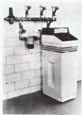
Wasserenthärter Six Madun Typ WA 5-20, Kompaktmodell mit herausnehmbarem Solebehälter, automatischer Regenera-tionsteuerung und Silberharz-Desinfek-
