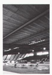
Kunsteisbahn Dübendorf 3900 m<sup>2</sup> Schichtex-Spezial 125/III im Format 200×64 cm mit allseitigem Falz, Sichtseite mit Strukturanstrich gelb.
