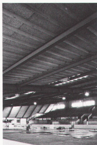
Kunsteisbahn Dübendorf 3900 m 2 Schichtex-Spezial125/III im Format 200x64 cm mit allseitigem Falz, Sichtseite mit Strukturanstrich gelb.
