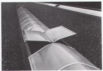
Teilansicht der 950 m² ISBA-**Lichtbänder** aus Plexiglas®-Stegdoppelplatten mit pneumatisch gesteuerten Lüftungs-
