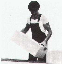
1 Gemauert als monolithisches, homogenes Fassadenmauerwerk mit dem k-Wert 0,24 W/m²K bei 35 cm Wandstärke, Qualität GL und 5 Gew.-% = Feuchtigkeit.
