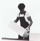
1 Gemauert als mono-lithisches, homogenes Fassaden-mauerwerk mit dem k-Wert 0,24 W/m²K bei 35 cm Wandstärke Qualität GI und 5 Gew.-%= Feuchtigkeit.
