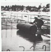
Die Ethafoam-Schaumstoffmatte wird direkt am Benützungsort mit einem gewöhnlichen Messer zugeschnitten. Der Schaumstoff widersteht Öl, Benzin, Lösungsmitteln usw.
