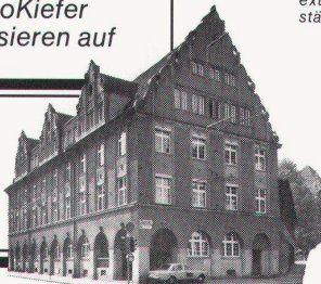
Verwaltungsgesellschaft in Winterthur, ZH. Altbau renoviert mit Kunststoff-Fenstern und Isolierverglasung.
