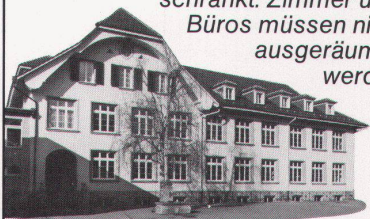
Schulhaus in Bremgarten, BE. Altbau renoviert mit Holz-Wechselrahmen-Fenstern und Isolierverglasung.
