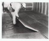
Das Unternehmen hat sein Fussbodensystem verbessert und liefert ab Januar 1979 ausschliesslich 3lagige Unterbodenelemente. Dies erhöht die Stempeldurchbruchlasten (5,2 kN). Eine neue Falzausbildung (Nut und Feder) erleichtert das Verlegen und verbessert die Verbindung der Elemente.
