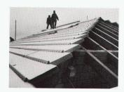
Diese Elemente, die in den Stärken 60 mm (k-Wert 0,39) und 85 mm (k-Wert 0,29) erhältlich sind, werden direkt auf die Dachbalken aufgenagelt und bilden ein vollflächiges, dichtes Dach, welches nur noch mit Ziegeln belegt werden muss. Alle weiteren Arbeitsgänge – wie Verschalung, Aufbringen von Konterlatten und Dachlatten sowie von Wärmedämmungsmaterialien – entfallen.
