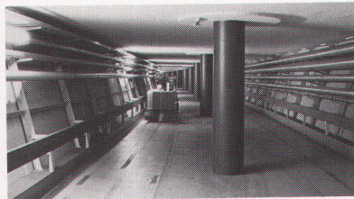
Transportkanal für Handgepäck im Flughafenbahnhof Kloten. VERMIPAN-Platten, 40 mm dick. Totale Wandlänge ca. 1200 Meter.
