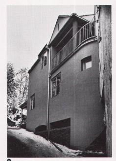
kragen über die Felskante vor und stützen sich mit drei Scheiben am Felsen ab. Das Gestein ist an den Fusspunkten dieser Scheiben mit langen Stahlankern und Betonmanschetten gesichert.
