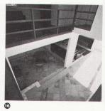
Klinkermauerwerk ausgefacht. Das Muster der Klinker verweist auf eine Köperbindung, also auf den textilen Ürsprung von nicht tragenden Wänden. Semper leitet das Wort Wand von Gewand ab. Auf den tragenden Wandscheiben liegt die nach allen Seiten auskragende, in der Höhe abgesetzte Stahlbetonplatte auf. Durch diesen Niveausprung und durch teilweises Absenken des Erdgeschossbodens wurden, trotz der vorgeschriebenen Bauhöhe, im ganzen Haus brauchbare und differenzierte Raumhöhen erreicht.
