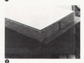
AG in Bad Ragaz wurden in diesen Tagen 2600 m<sup>2</sup> dieser neuartigen Sichtelemente verlegt. Ohne diese Unterdach-Isolation wäre die grosse Tennishalle mit dem riesigen Raumvolumen fast nicht zu heizen. Im Sommer schützt die Isolation vor Hitze. Bereits haben verschiedene Baufachleute die neue Unterdach-Isolation am Hallenneubau in Bad Ragaz inspiziert.
