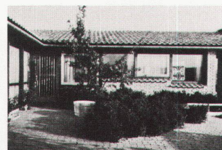
48. Die Kingohäuser liegen am Kingsøvej in Helsingør, etwa 40 km nördlich von Kopenhagen. Sie wurden 1958/59 von Architekt Jørn Utzon errichtet. Die Atriumhäuser können in der Höhe und im Grundriss verschieden zusammengestellt werden.
