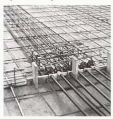
Ende eines Betonierabschnittes mit Zwischenabspannstelle der Spannkabel.
