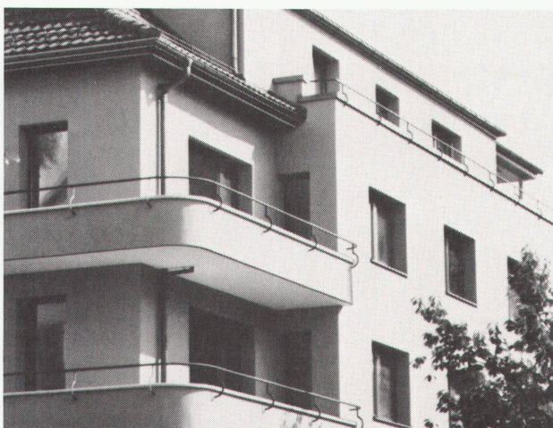
- Mehrfamilienhaus-Sanierung, Dübendorf. 1980. Aussenisolation.
