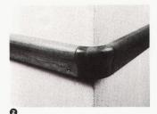
00 Eckausbildung mit gedrechseltem 90°-Massivholzteil und Metallbügel aus Chromstahl
