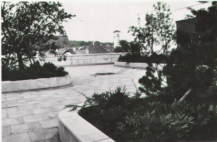
Objekt: Migros Madretsch, Biel 1980, ca. 250 m 2 Dachbegrünung, Schichthöhe 35cm Architekt: Dubler und Müller, Bern. Ausführung: Hans Bracher AG , Bern.
