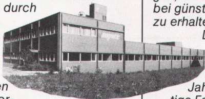
Industriebau in Liestal, BL. Neubau mit Kunststoff-Fenstern.
