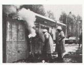
Die neuentwickelten Panzerelemente der Bauer Kassenfabrik AG sind eingehenden Prüfungen unterworfen. Das Bild zeigt den Test mit der Sauerstofflanze, einem der gefürchtetsten Angriffswerkzeuge.
