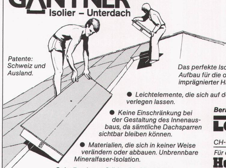
Das perfekte Isolier-System mit dem logischen Aufbau für die optimale Vollisolierung. Mit überlappender, imprägnierter Hartfaserplatte.
