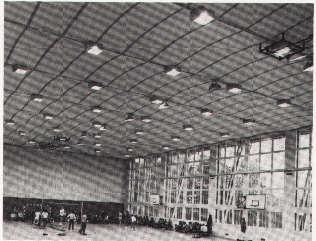
- Turnhalle Magglingen. Turnhallenboden-Sanierung.
