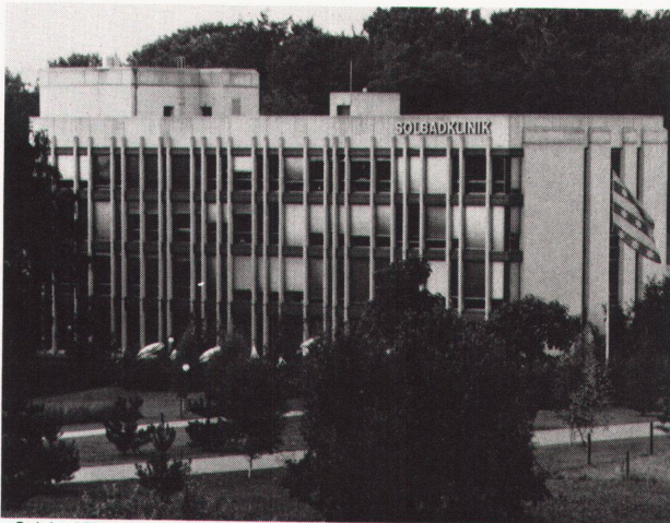
- Solebad Rheinfelden. Bodendämmung auf Erdreich.
