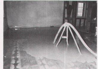
Der flüssige Renoplanit®-Unterlagsboden wird über eine Schlauchleitung auf die Heizfläche gepumpt. 48 Stunden später ist er bereits voll belastbar.
