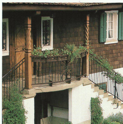
Fassaden-Renovation eines Original Luzerner Bauernhauses, Eschenbach. Qualität Nr. 1.
