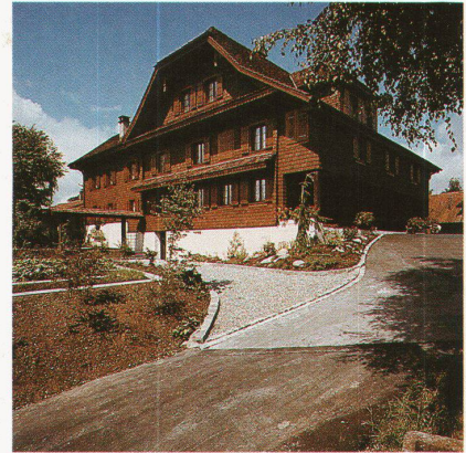
Fassaden-Gestaltung eines Bauernhauses in Meggen. Qualität Nr. 1, oberflächenveredelt.
