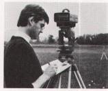
Citation Das neueste elektronische Vermessungsin-strument im Wild-Programm: der reduzierende Infrarot-Distanzmesser Citation CI-450. Bemerkenswert ist das grosse Bedie-nungs-/Ablese-Panel. Der CI-450 ist hier auf den Skalentheodolit Wild T16 aufge-
