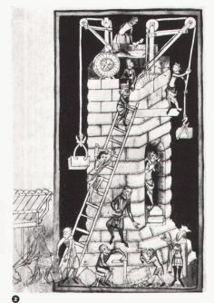
Es ist daher eine Hypothese, wenn Binding im «Mittelalterlichen Baubetrieb» meint, dass «das Auslegergerüst und das fliegende Gerüst die gängige Bauweise des Mittelalters ist». Da im 15. Jh. grösser gebaut wurde als im 12., ist es auch verständlich, dass Stangengerüste erst später mit Diagonalverstrebungen vorherrschen.
