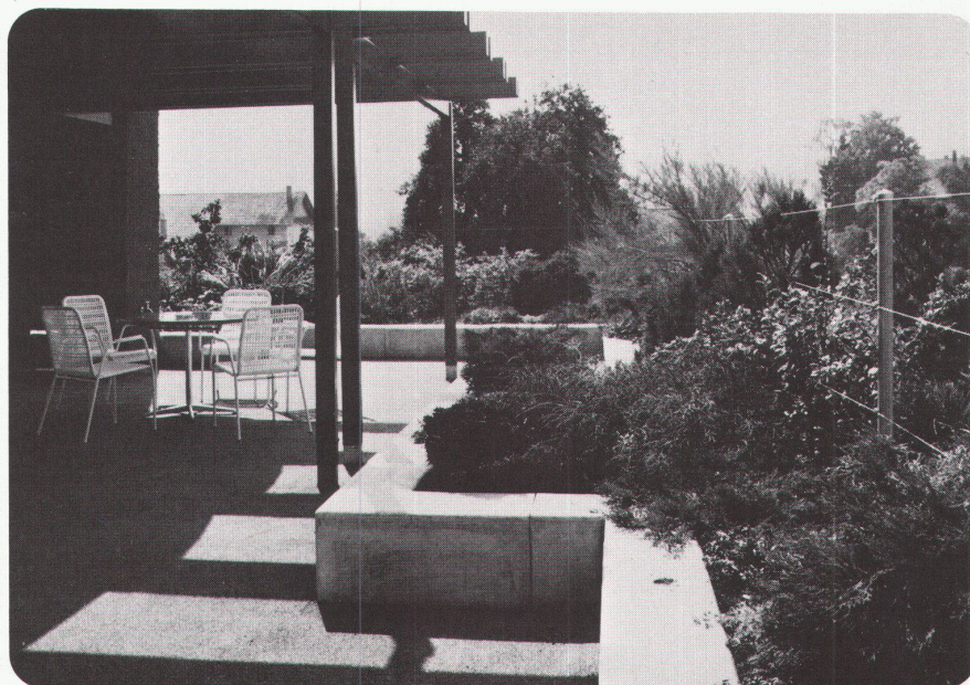
Objekt: Alters- und Krankenhaus Seuzach ZH, ca. 600 m 2 Dachbegrünung, Schichthöhe 35 cm. Planung: Architekten Isler + Isler + Zirn, Winterthur. Ausführung und Gartengestaltung: A. Bachmann und Sohn, Winterthur.
