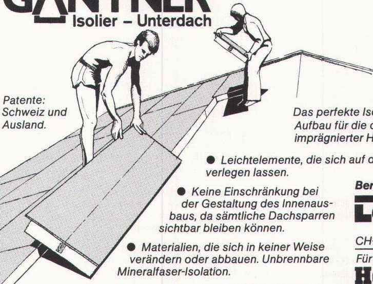
Das perfekte Isolier-System mit dem logischen Aufbau für die optimale Vollisolierung. Mit überlappender, imprägnierter Hartfaserplatte.
