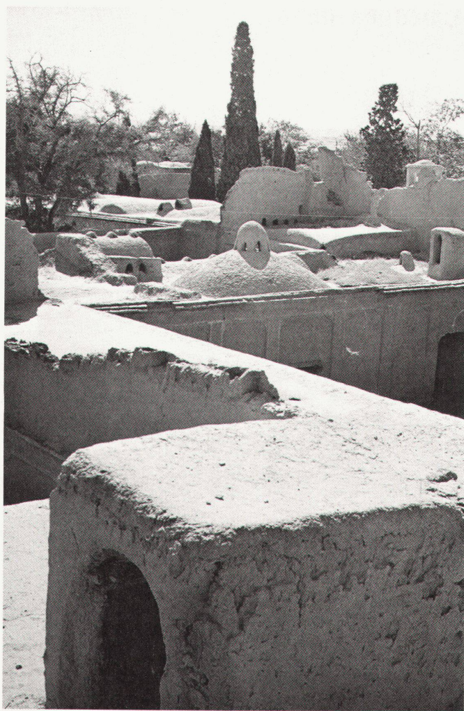
Begehbare Flachdächer und Lüftungstürme in Gonabad
