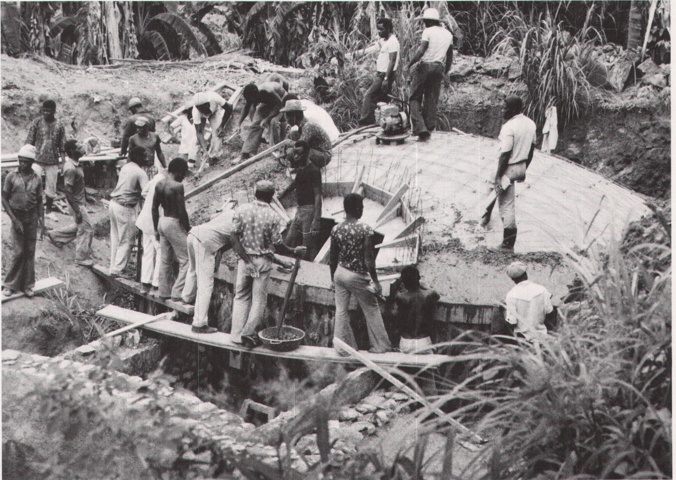
3 Helvetas: Aufbau dörflicher Wasserversorgungen in Kamerun. Betonieren einer Reservoir-Kuppel / Helvetas: établissement d'un ravitaillement en eau dans des villages au Cameroun. Voûte d'un réservoir en train d'être coulée.
