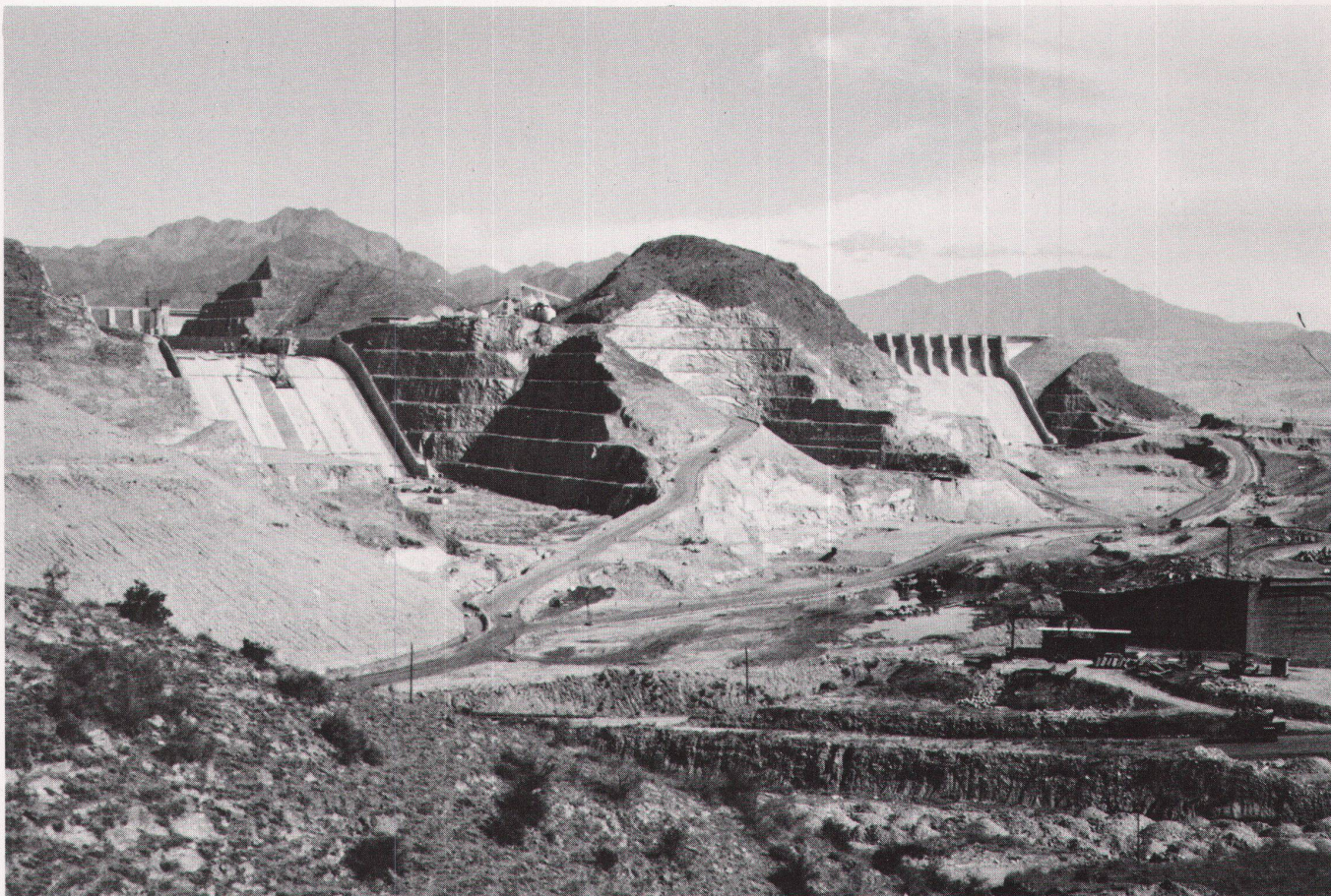
1 Losinger AG, Bauunternehmung, Bern: Tarbela-Staudamm, Pakistan / Losinger SA, Berne: barrage Tarbela, Pakistan
