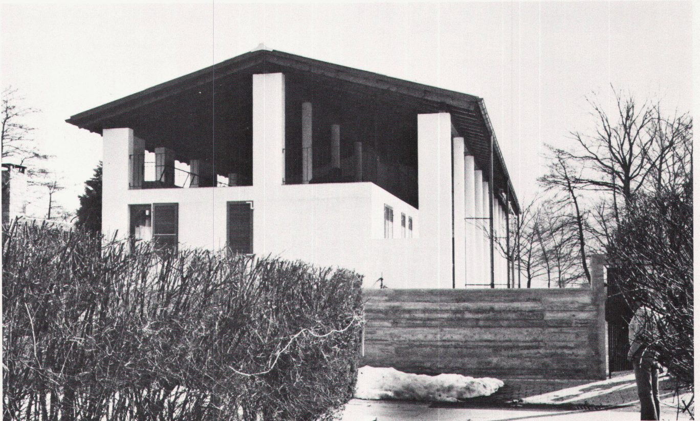
25 Westansicht/vue côté ouest
