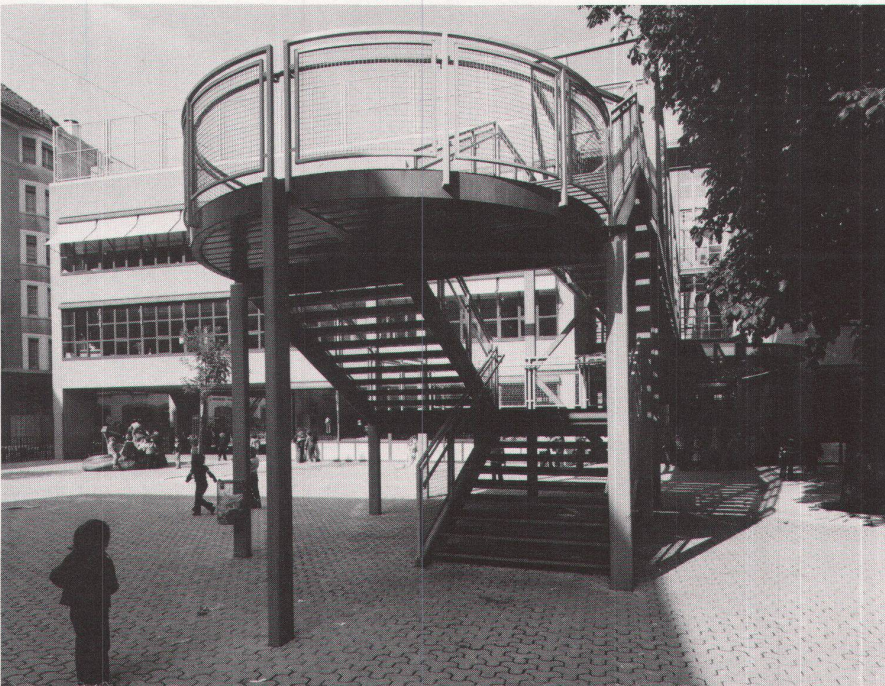
5 Ausgang zur Passerelle/montée à la passerelle
