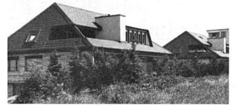
Der Architekt, zugleich einer der beiden Bauherren, benützte nun das Flachdach als Geschossdecke und baute darüber einen Dachstuhl. Eine zeitgemässe Dachkonstruktion mit braunen Dachschiefeln «Eternit» und gu-
